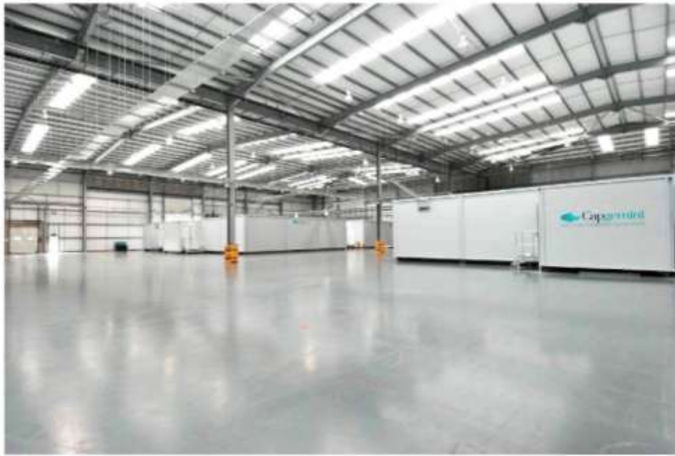
Nova zgrada centra podataka s modularnim jedinicama
